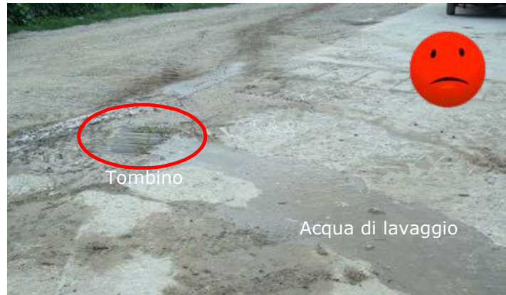
Fig. 98 – Acque di lavaggio immerse direttamente nella rete fognaria.
