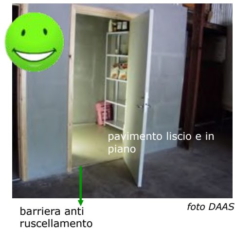
Fig. 25 – Il locale per lo stoccaggio degli agrofarmaci deve essere dotato di pavimento liscio e non scivoloso.
