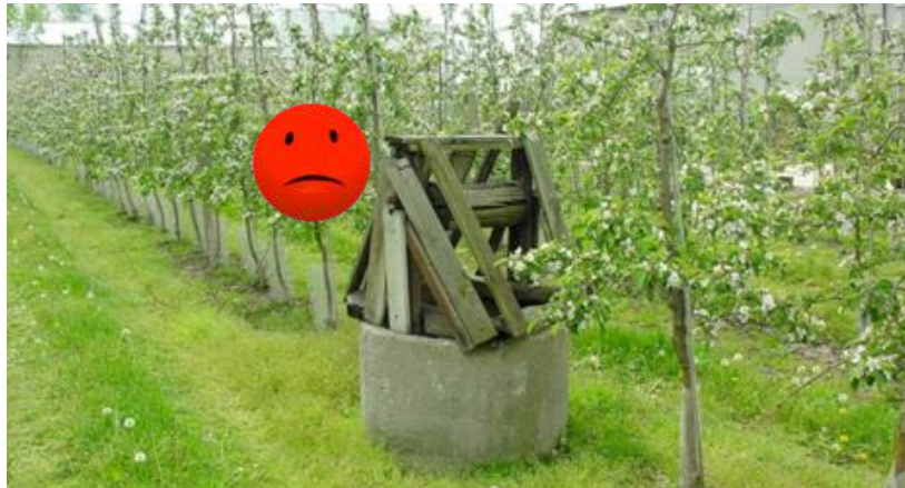
Fig. 69 – Pozzo non adeguatamente protetto (Foto ISK)
